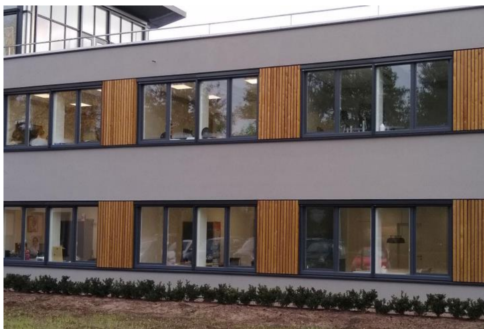
Gerenoveerd kantoorgebouw Cello, Rosmalen
