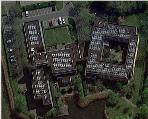
Locatie Geestercogge van GGZ NHN. Veel van de voor de warmtepomp benodigde elektriciteit wordt door de zonnepanelen opgewekt.
